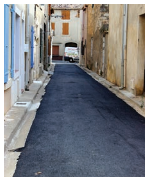
Remise en état de la rue de Pérignan
